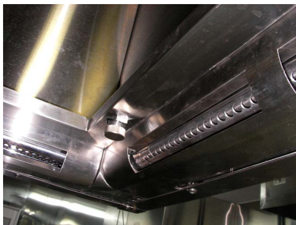
「写真一1 DRV 回転 NEF・停止時」
